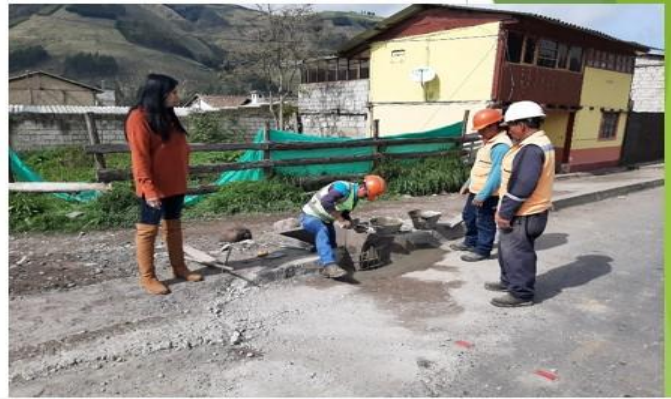
Creación de una rejilla para desfogar las aguas lluvias en el Barrio San Vicente
